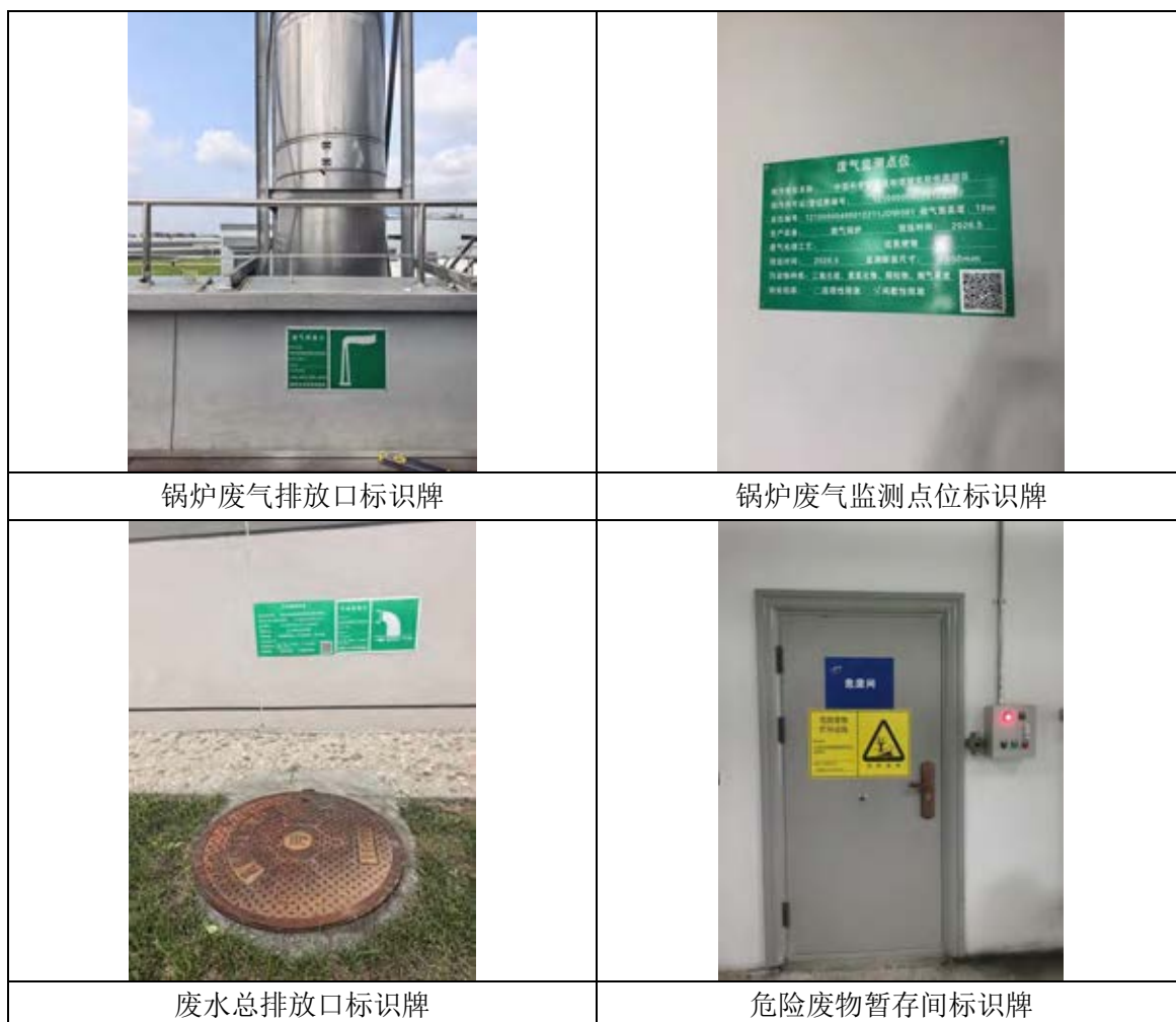
图 6.2-1 排污口标识牌现场照片
