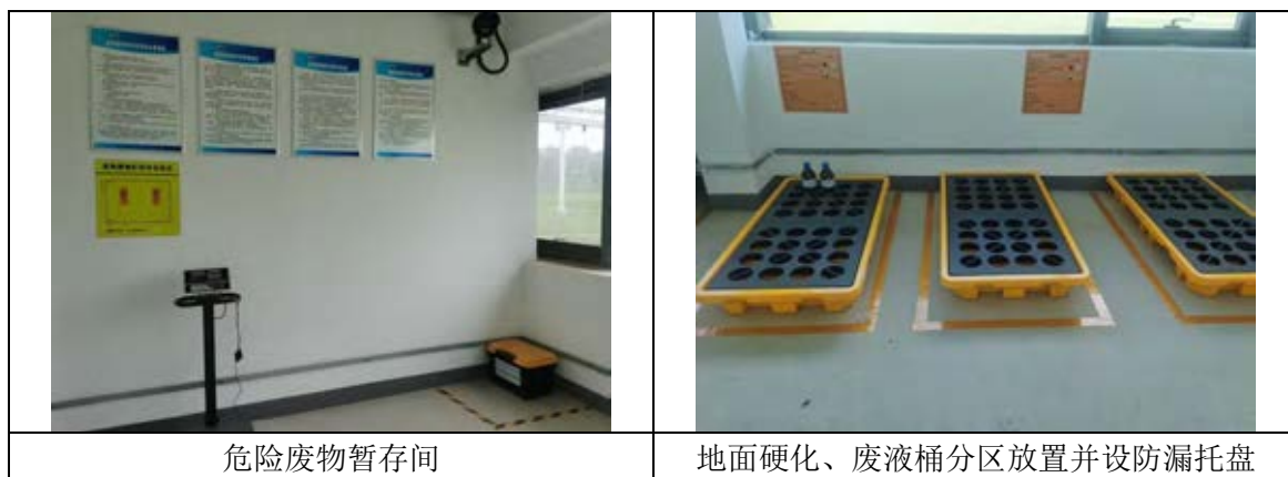
图 6.1-5 危险废物暂存间
