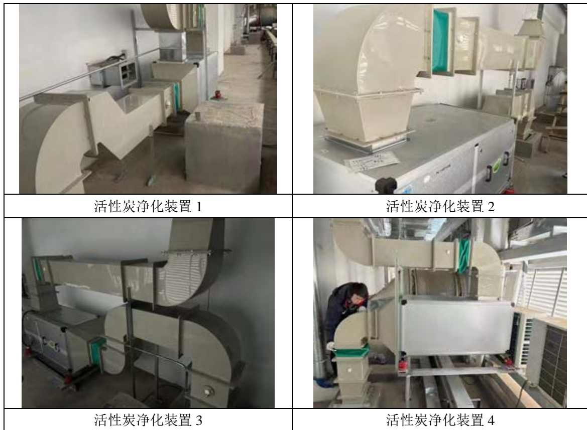
图 6.1-3 辅助实验室活性炭净化装置
